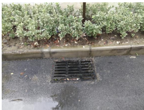
小区内雨水井
