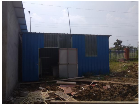
共建污水处理站
