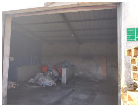
一般固废暂存场所
