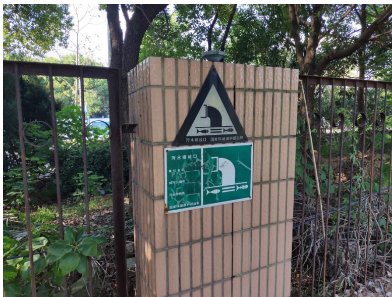
图 4-2 厂区污水总排口
