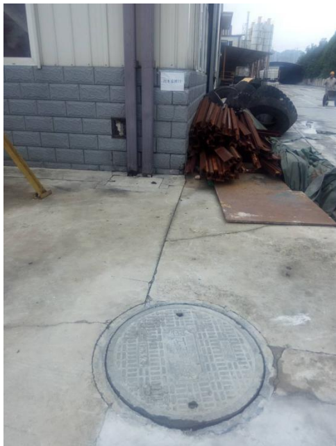
生活污水总排口
