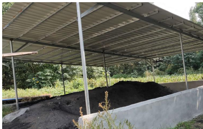
灰渣临时堆场
