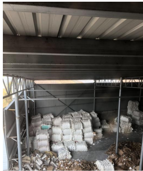
一般固废暂存场所
